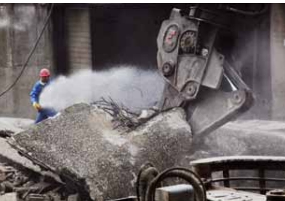
Das Rote Haus soll rekonstruiert werden
